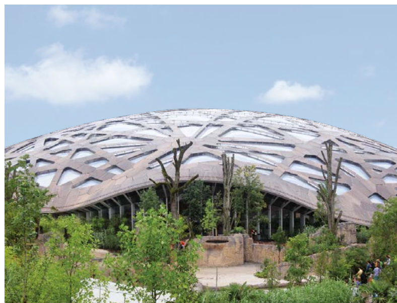
esb im Objektbau: Elefantenhaus in Zürich
